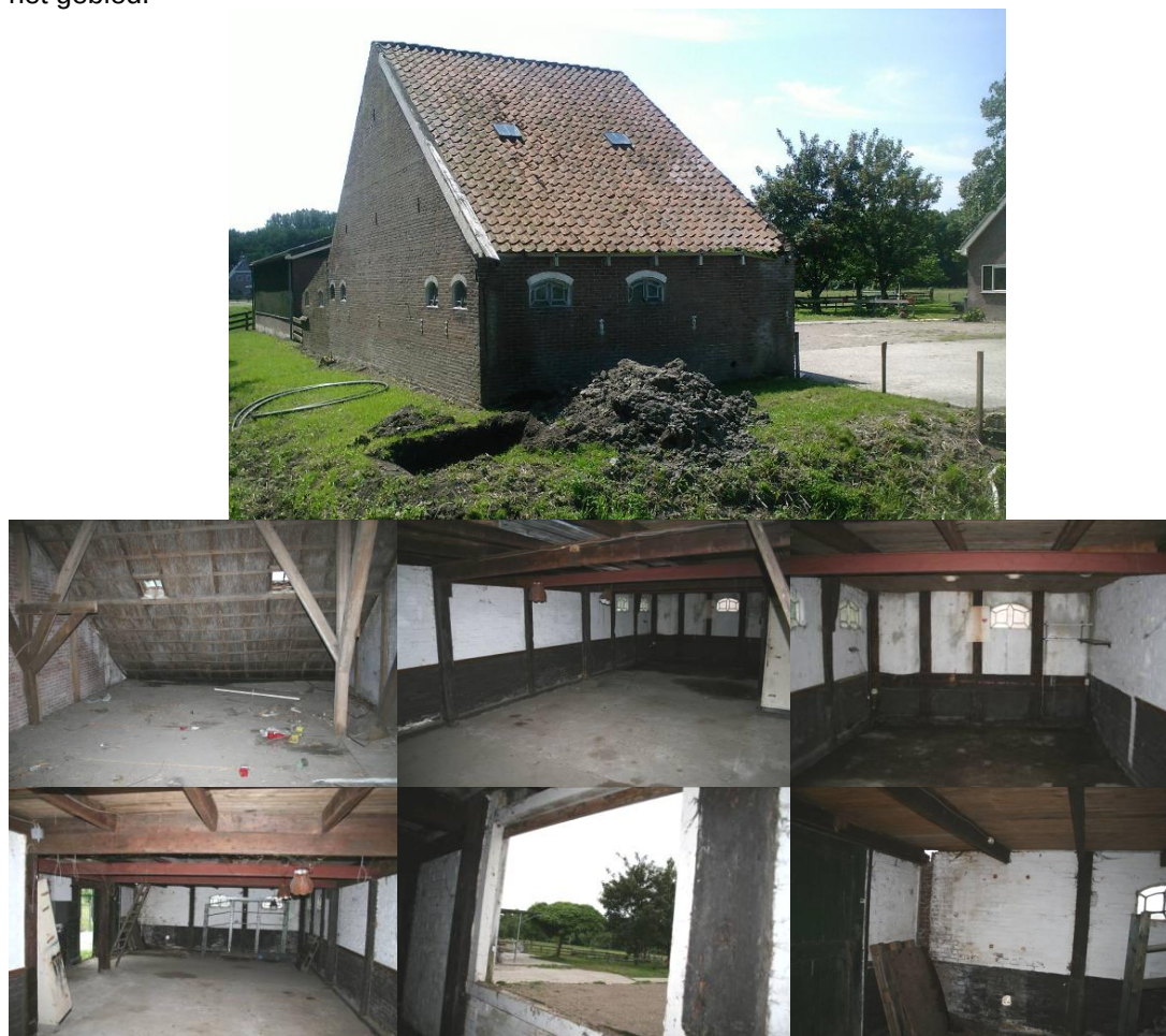
Figuur 3.1 te slopen schuur in het plangebied
