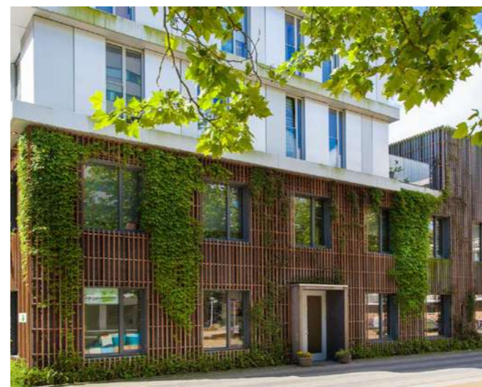
Groene gevels waar de daktuin zichtbaar is.
