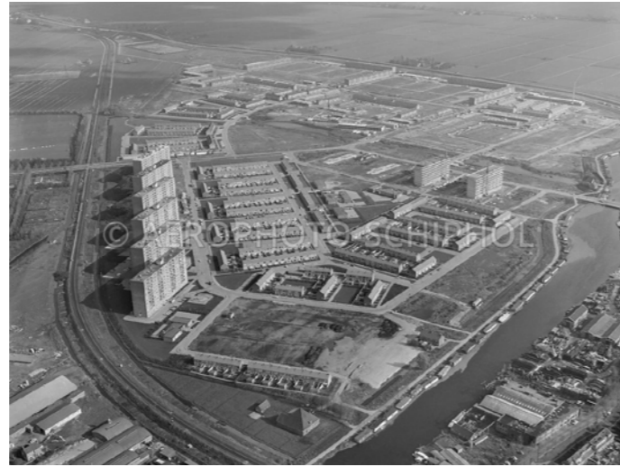
Luchtfoto Wheermolen in aanbouw 1968
