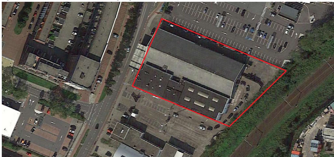
Figuur 2: Overzicht onderzoekslocatie (gelegen binnen rood kader)
