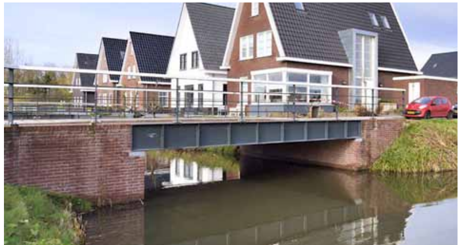
bruggen langs het Middenpad met gemetselde landhoofden en een stalen leuning
